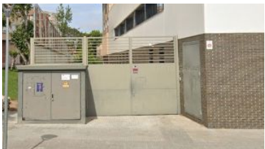
CARRETERA DE LA VILA (Esquerra i dreta)
